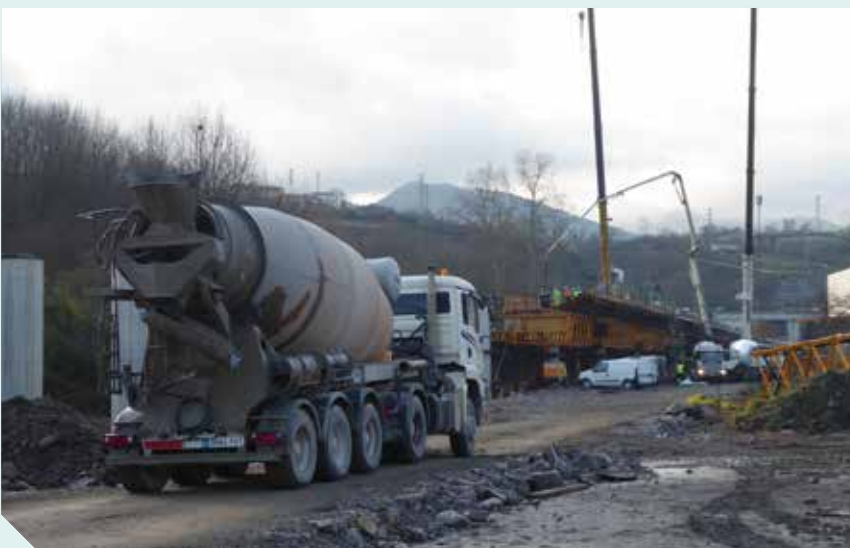
En la imagen, obras del TAV
