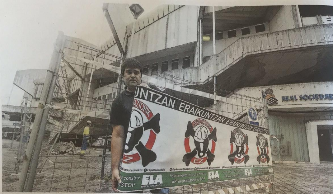
Igor San José, responsable de la Construcción de ELA, protesta con una pancarta delante de las obras que se están llevando a cabo en el estadio de Anoeta.
