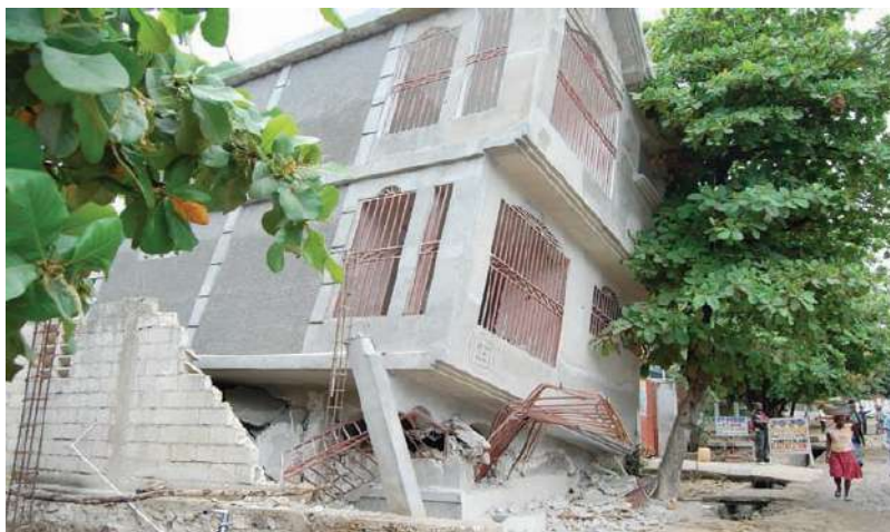
Edificio afectado Haití 2010
