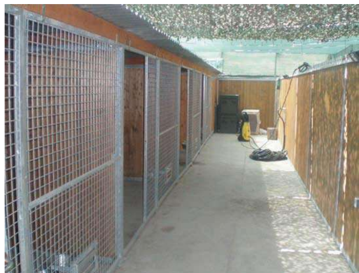
Núcleo canino en la base de Herat (Afganistán) montado sobre una solera de hormigón para 4 perros detectora de explosivos y cubierto con red mimética
